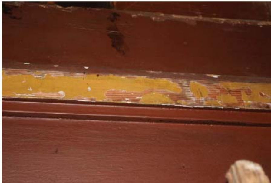
Dobre Miasto, bazylika, prospekt organowy, fragment listwy w cokole prospektu; widoczne ubytki złoceń
